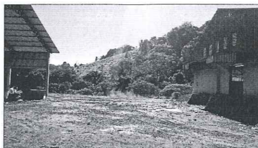
FOTO 3 - Neste vão entre o barracão dos fundos e o da frente será coberto. Existe um desnível do barracão da frente em relação ao dos fundos de 1.50m.
