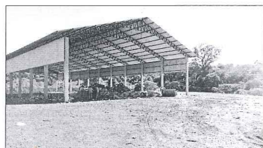
FOTO 1 - Vista do barracão dos fundos ao qual será implantado o ECOPONTO.
