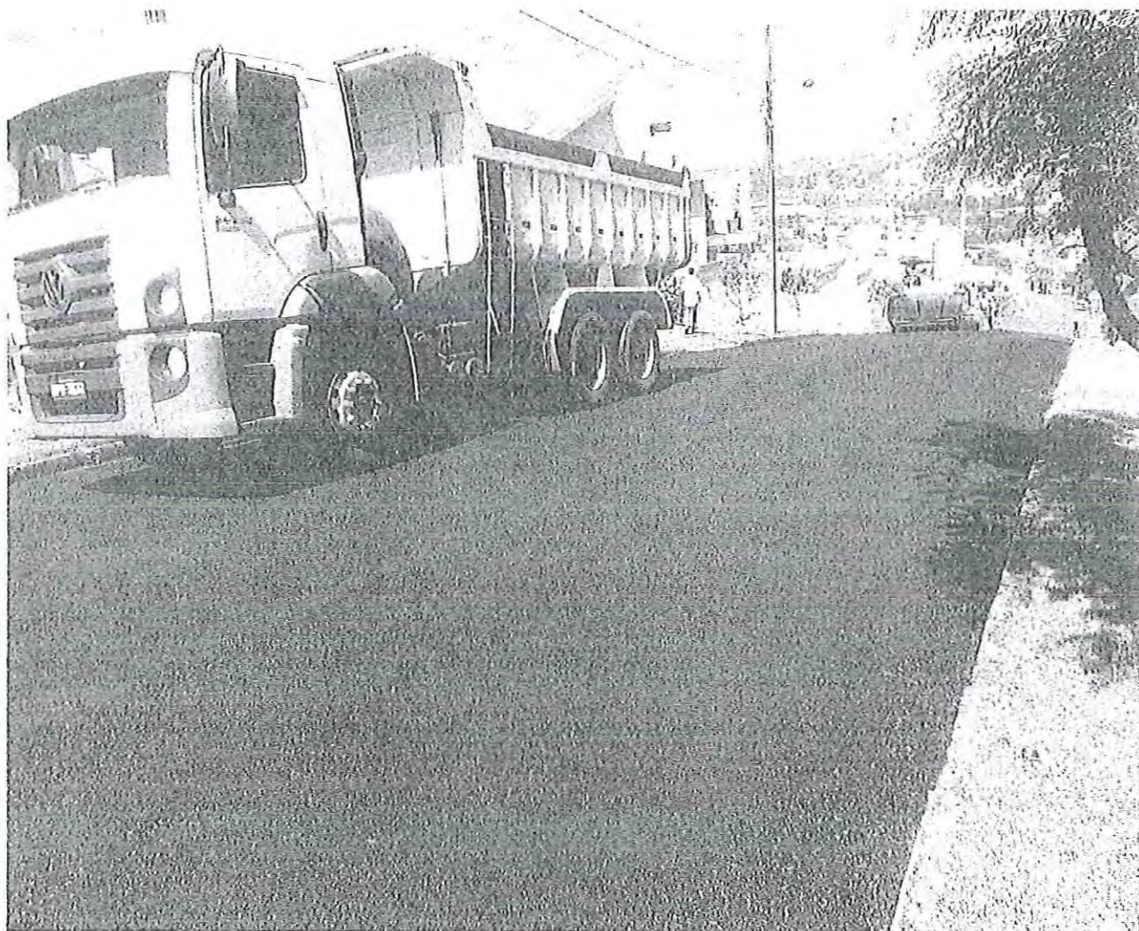
Fotografia 01 - Rua Roald Carraro, entre a Rua Arthur Bernardes + 28,5 m e Rua Tocantins
