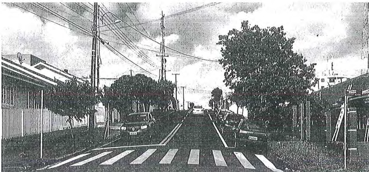
Fotografia 05–Rua Carlos Tumelero, entre a Rua Bolislau Fidalski e a Rua Urbano Witiman
