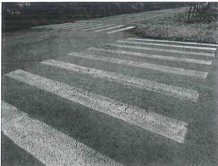
Foto 01- Trincas interligadas sem erosão acentuada nas bordas próximo a curva na continuação da Rua Irineu Parzianello
