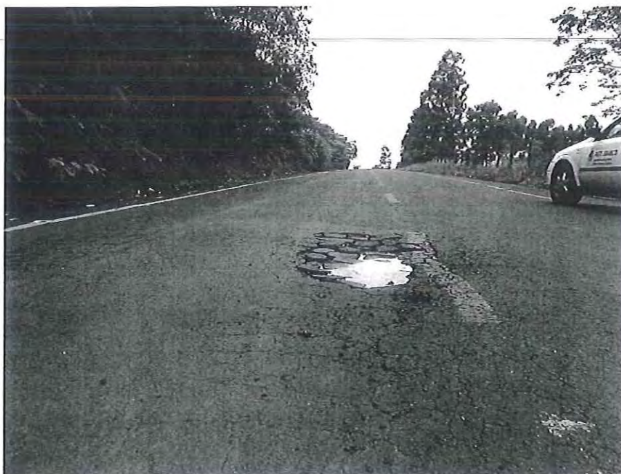
Foto 09 - Panela no trecho entre a continuação da Rua Irineu Parzianello e o acesso a UTFPR
