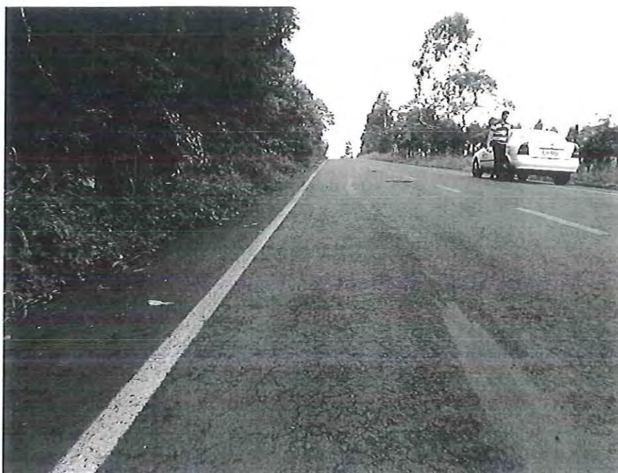
Foto 02 - Trincas interligadas sem erosão acentuada nas bordas no trecho entre a continuação da Rua Irineu Parzianello e ao acesso a UTFPR
