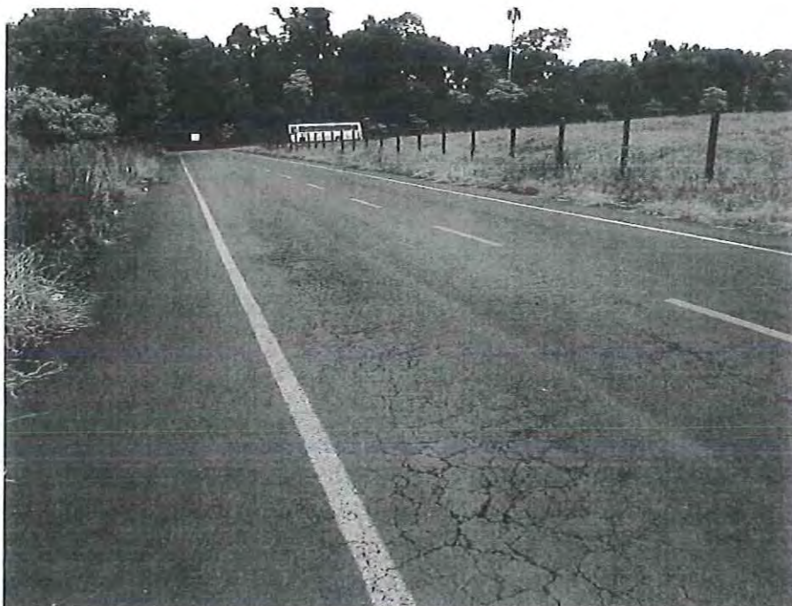
Foto 04 - Trincas interligadas com erosão acentuada nas bordas no trecho entre a Rua Luiz Detoni e a continuação da Rua Irineu Parzianello
