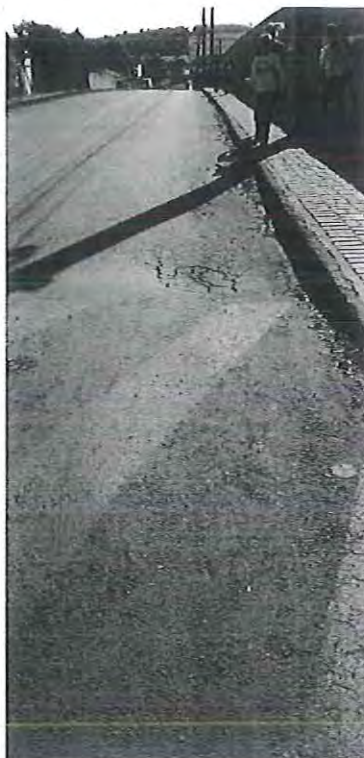
Foto 02: Trinca tipo "couro de jacaré" - Rua Mohamad Omar Awada (próxima a lombada)
