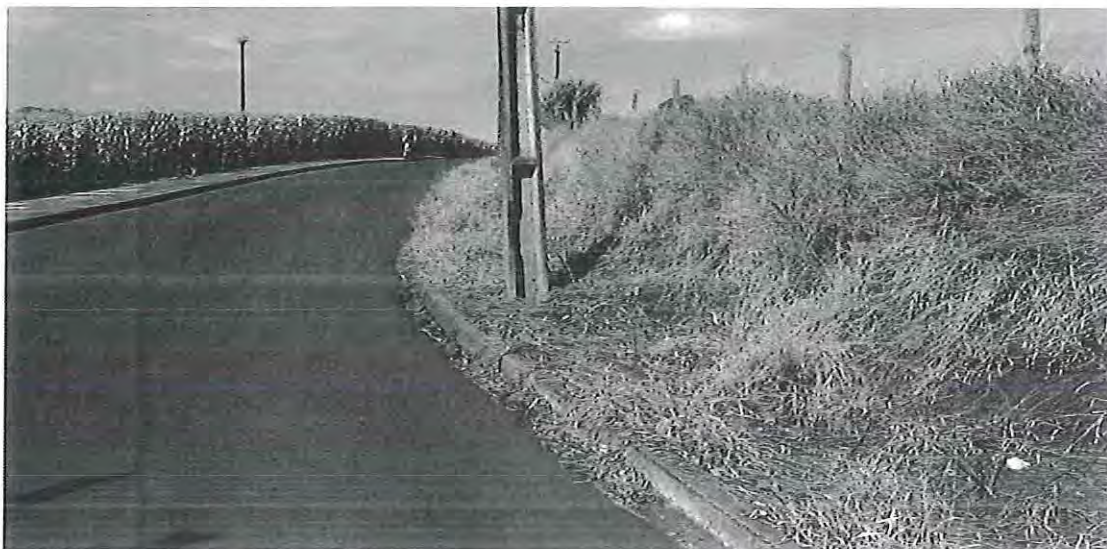
Foto 09: Despreendimento entre asfalto e meio fio (curva) - Rua Setembrino Tomazzi
