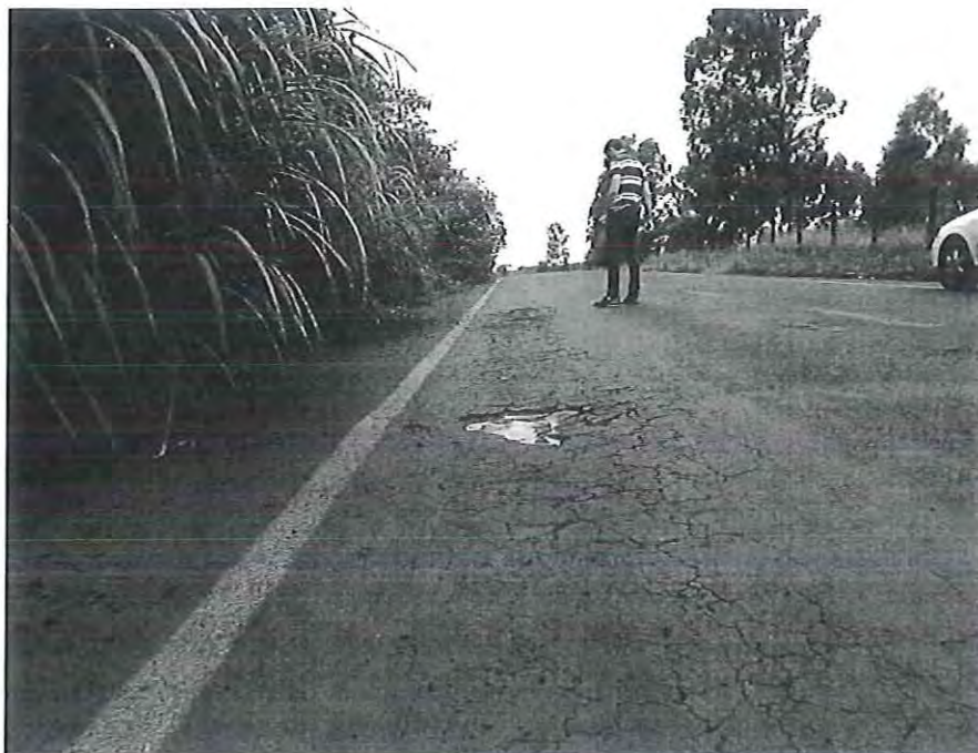
Foto 10 - Panela no trecho próximo ao acesso a UTFPR
