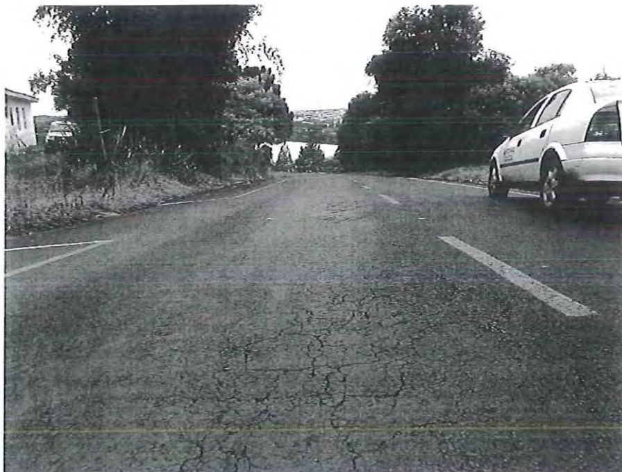
Foto 06 - Afundamento plástico da trilha de roda, próximo ao acesso a UTFPR
