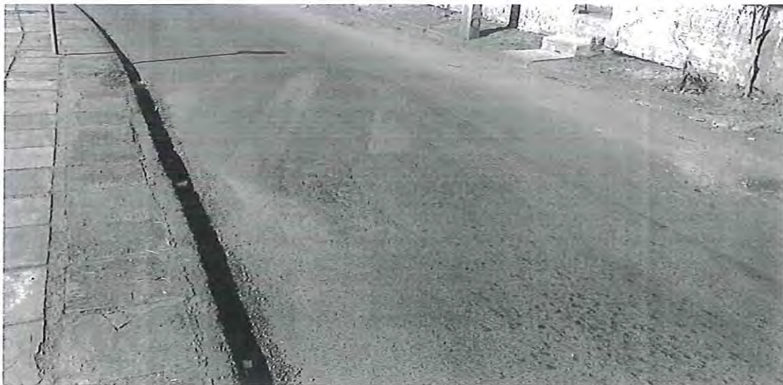
Foto 01: Trinca tipo "couro de jacaré" - Rua Setembrino Tomazzi (próxima a lombada)
