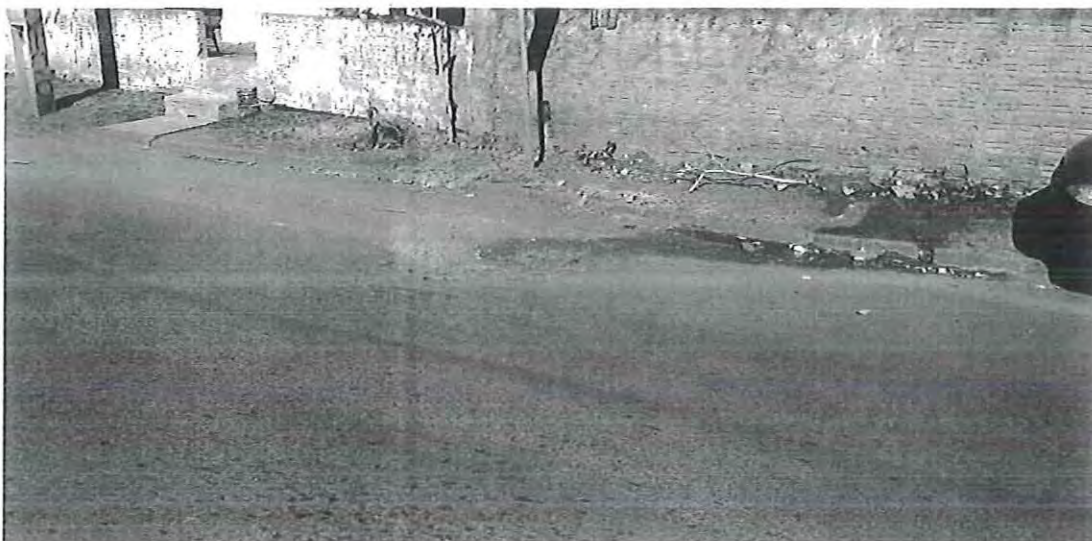
Foto 04: Afundamento plástico - Rua Setembrino Tomazzi (próximo a lombada)
