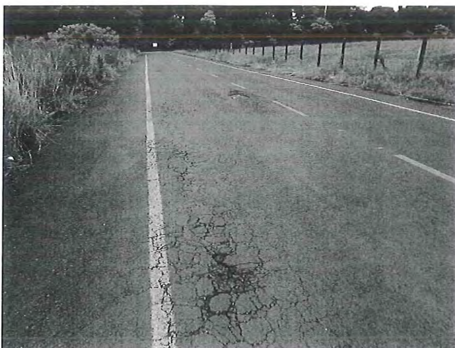
Foto 03 - Trincas interligadas com erosão acentuada nas bordas no trecho antes da continuação da Rua Irineu Parzianello
