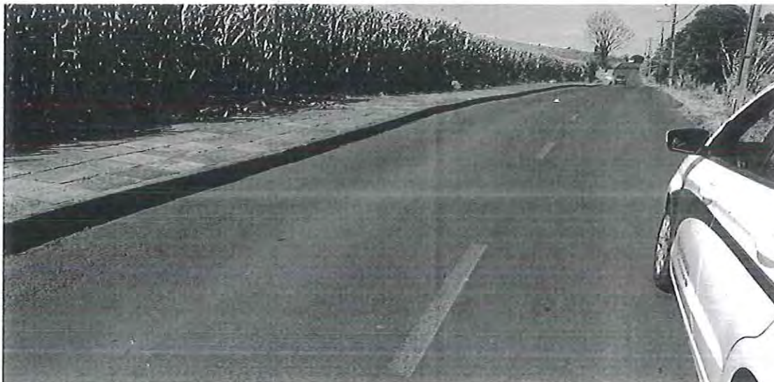
Foto 07: Afundamento plástico ao longo da rua - Rua Setembrino Tomazzi
