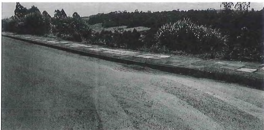
Foto 06: Afundamento plástico - Rua Setembrino Tomazzi (próximo a lombada)
