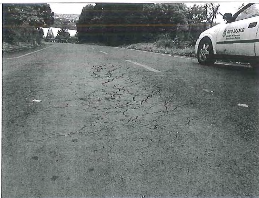
Foto 07 - Afundamento plástico da trilha de roda
