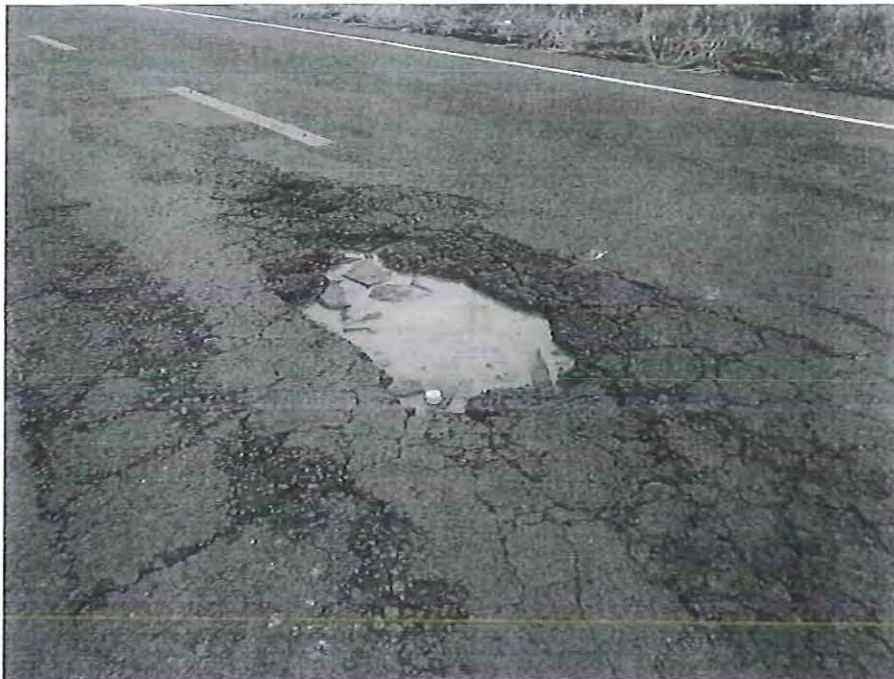
Foto 08 - Panela no trecho entre a Rua Luiz Detoni e a continuação da Rua Irineu Parzianello
