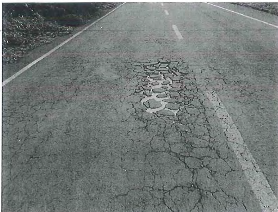
Foto 05 - Trincas interligadas com erosão acentuada nas bordas no trecho próximo ao acesso a UTFPR
