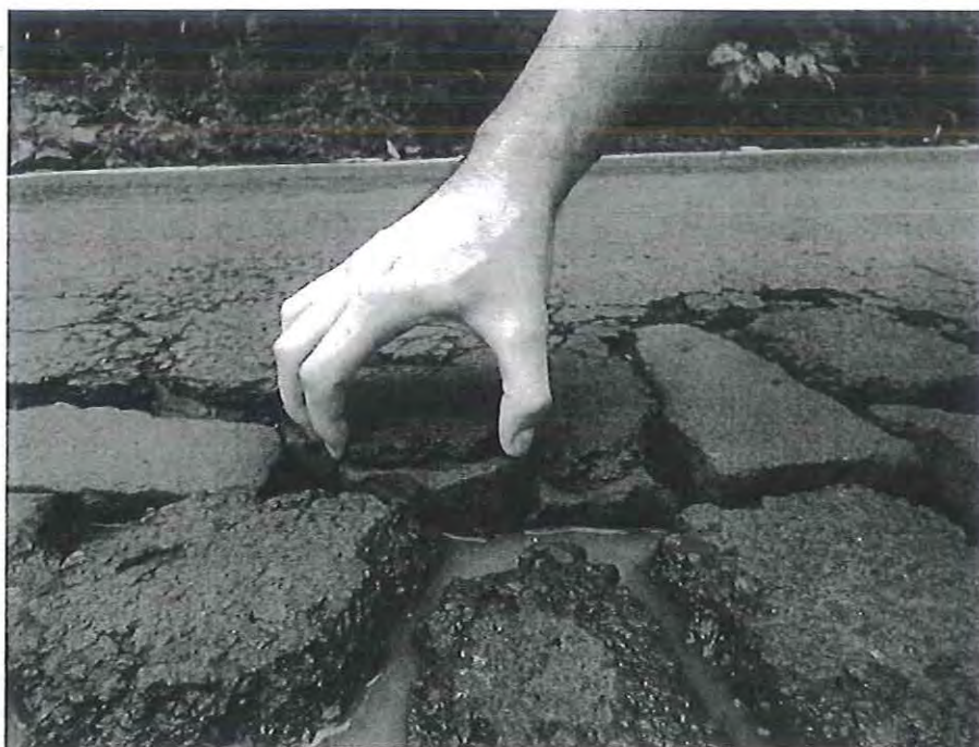
Foto 13 - Espessura do asfalto no trecho entre a continuação da Rua Irineu Parzianello e o acesso a UTFPR
