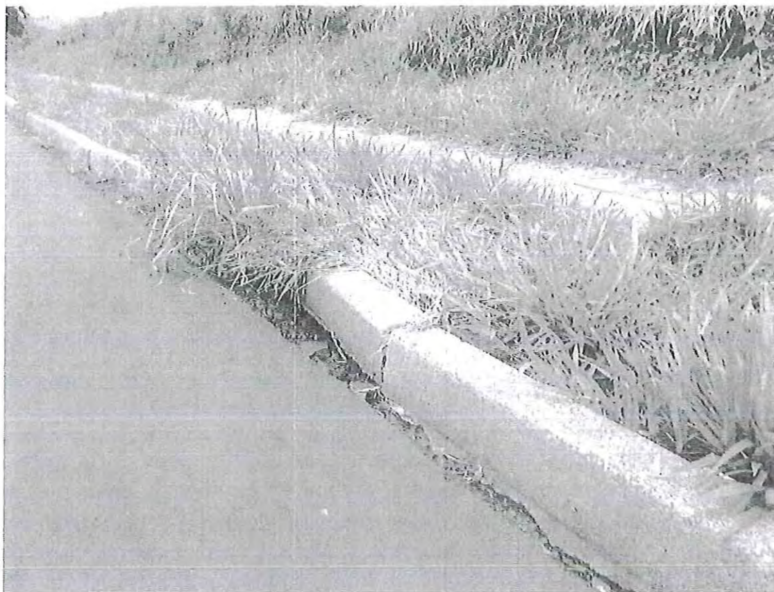
Foto 01: Abertura entre a pista e o meio-fio.
