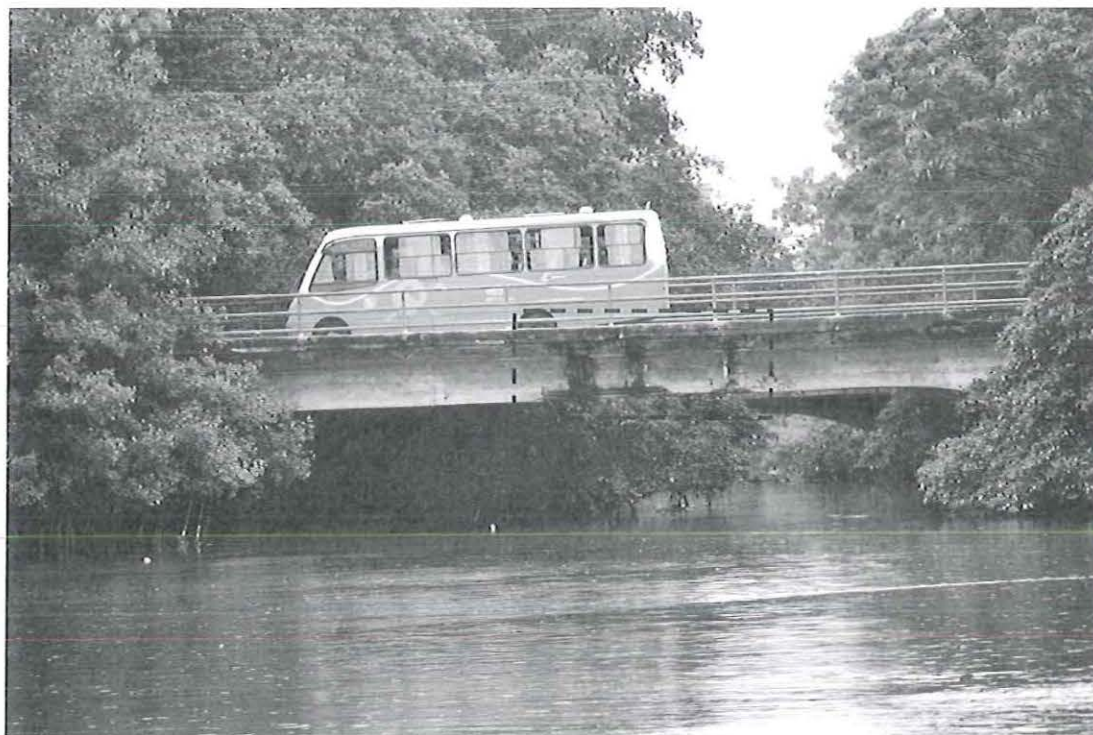
Figura 1 – Perda de cobrimento do concreto e armadura exposta em avançado estado de corrosão em local onde há maior solicitação de tensões da longarina da ponte
