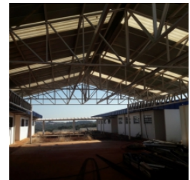
Vista do pátio coberto
