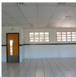
Vista interna do bloco pedagógico esquerdo
