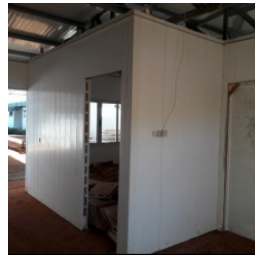
Vista interna do bloco administrativo
