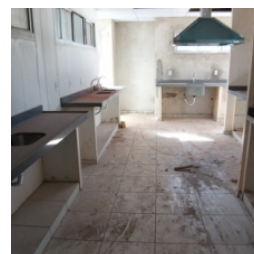
Vista interna do bloco de serviço
