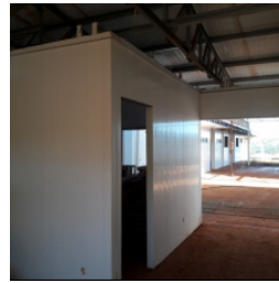
Vista interna do bloco administrativo
