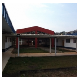
Vista geral da obra
