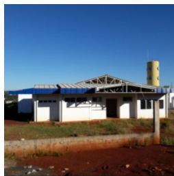
Vista frontal da obra
