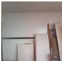
Vista interna do bloco de serviço
