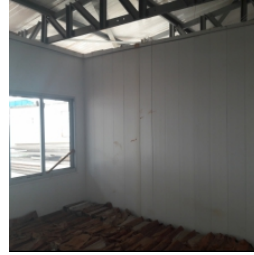
Vista interna do bloco administrativo
