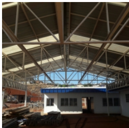
Vista do pátio coberto
