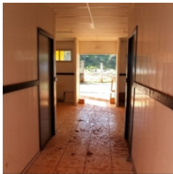
Vista interna do bloco administrativo
