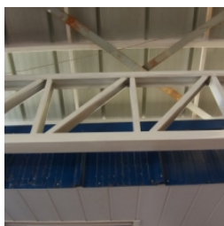
Vista do pátio coberto - início da remoção e repintura da estrutura metálica
