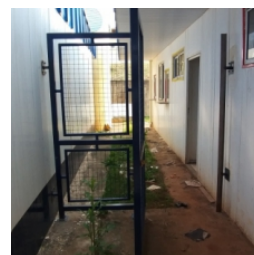
Vista do gradil entre o bloco de serviço e o bloco pedagógico direito
