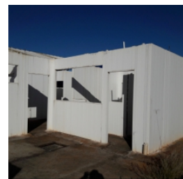
Vista do bloco de serviço
