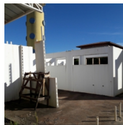
Vista do bloco de serviço
