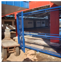
Execução parcial do gradil entre o bloco de serviço e o bloco administrativo
