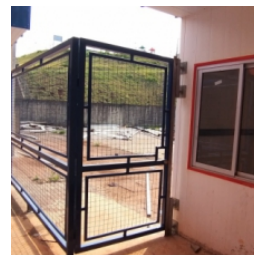
Vista do gradil entre os blocos administrativo e de serviço
