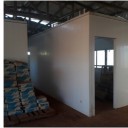
Vista interna do bloco administrativo
