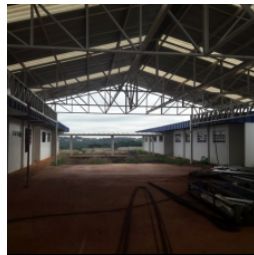
Vista do pátio coberto
