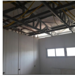
Vista interna do bloco pedagógico
