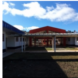
Vista geral da obra
