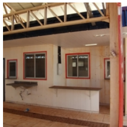
Vista externa do bloco de serviço
