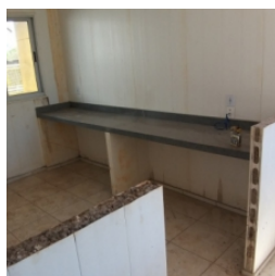
Vista interna do bloco de serviço
