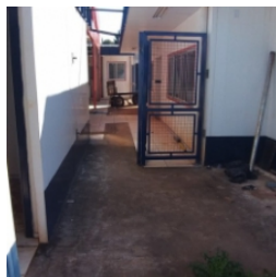
Vista da execução parcial do gradil entre o bloco administrativo e o bloco pedagógico esquerdo
