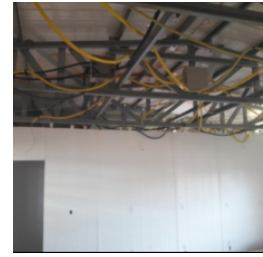
Vista interna do bloco pedagógico
