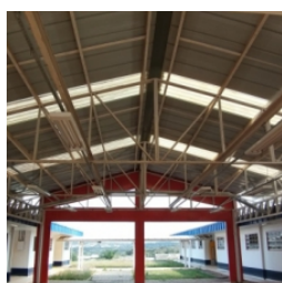
Vista do pátio coberto - iniciado o serviço de reparo na pintura
