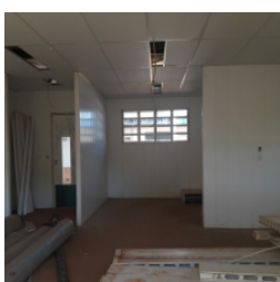
Vista interna do bloco pedagógico
