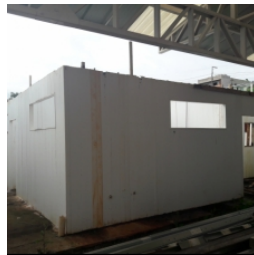
Vista do bloco de serviço
