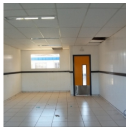
Vista interna do bloco pedagógico esquerdo
