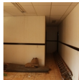
Vista interna do bloco administrativo
