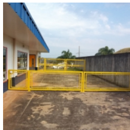
Vista dos gradis no solário do bloco pedagógico direito
