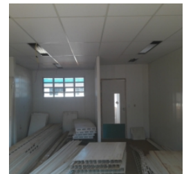
Vista interna do bloco pedagógico
