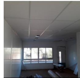
Vista interna do bloco pedagógico
