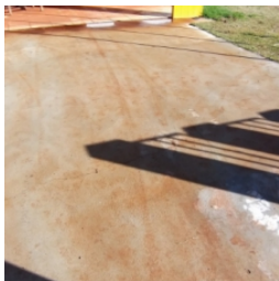
Vista do piso de acesso a obra
