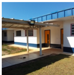
Vista do bloco pedagógico esquerdo
