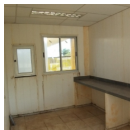
Vista interna do bloco de serviço
