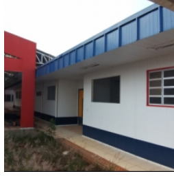
Vista do bloco pedagógico esquerdo
