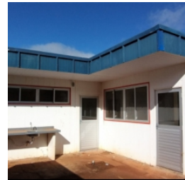
Vista externa do bloco de serviço
