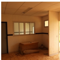
Vista interna do bloco administrativo
