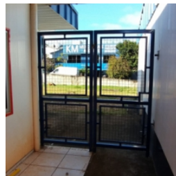
Execução parcial do gradil entre o bloco administrativo e o bloco pedagógico
