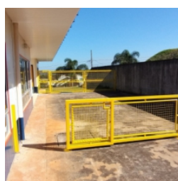
Vista do solário do bloco pedagógico direito -
