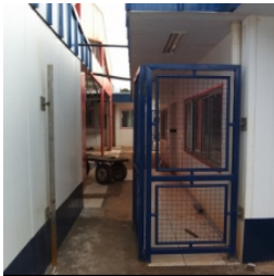
Vista do gradil entre os blocos administrativo e pedagógico esquerdo
