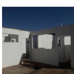
Vista do bloco de serviço
