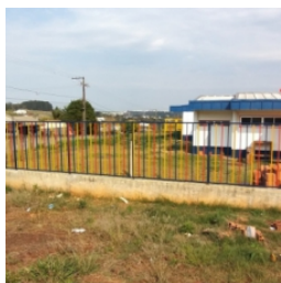
Vista frontal da obra - pintura dos gradis
