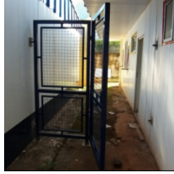
Execução parcial do gradil entre o bloco de serviço e o bloco pedagógico
