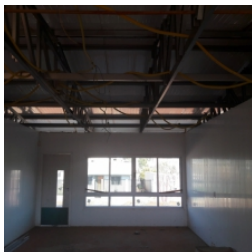
Vista interna do bloco pedagógico
