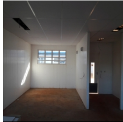
Vista interna do bloco pedagógico
