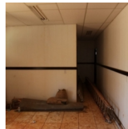
Vista interna do bloco de serviço
