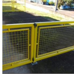
Execução parcial dos gradis no solário do bloco pedagógico lado esquerdo
