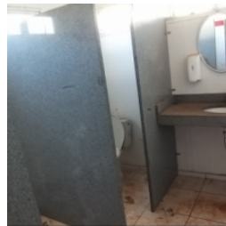
Vista interna do bloco administrativo
