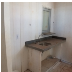
Vista interna do bloco de serviço
