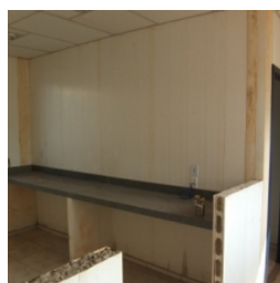
Vista interna do bloco de serviço
