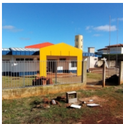
Vista frontal da obra
