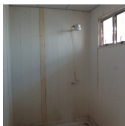
Vista interna do bloco de serviço
