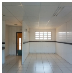
Vista interna do bloco pedagógico esquerdo
