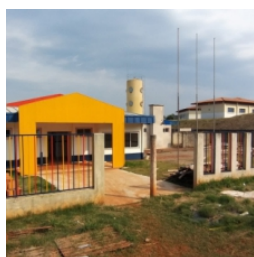
Vista frontal da obra - pintura dos gradis
