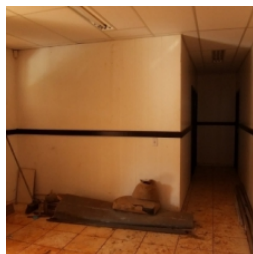
Vista interna do bloco administrativo
