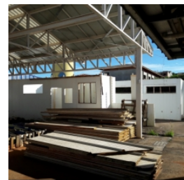
Vista do bloco de serviço
