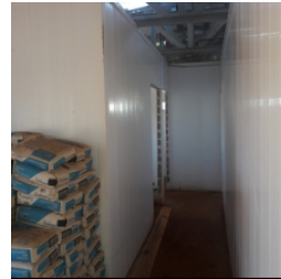
Vista interna do bloco administrativo
