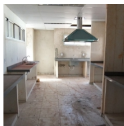
Vista interna do bloco de serviço
