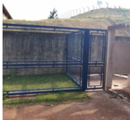
Vista do gradil atrás do bloco de serviço
