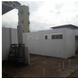
Vista do bloco de serviço
