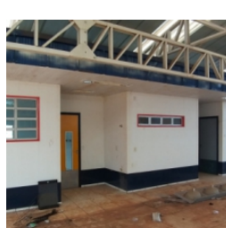
Vista do bloco pedagógico esquerdo
