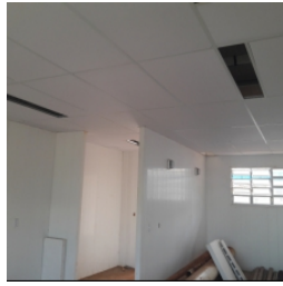
Vista interna do bloco pedagógico
