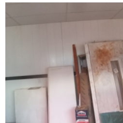
Vista interna do bloco administrativo
