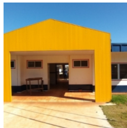
Vista frontal do bloco administrativo - execução do piso de concreto
