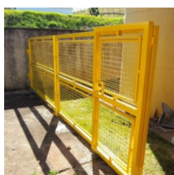
Vista do solário do bloco pedagógico direito
