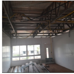
Vista interna do bloco pedagógico
