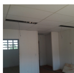
Vista interna do bloco pedagógico
