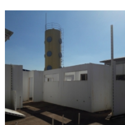
Vista do bloco de serviço
