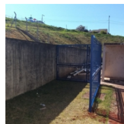
Vista dos gradis atrás do bloco de serviço
