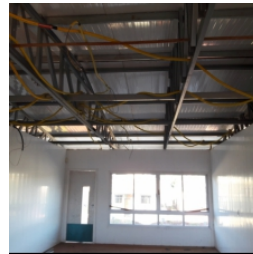
Vista interna do bloco pedagógico
