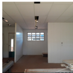
Vista interna do bloco pedagógico
