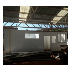
Vista do bloco de serviço
