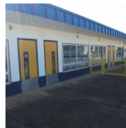
Vista do solário do bloco pedagógico esquerdo - instalação parcial dos gradis metálicos
