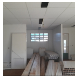
Vista interna do bloco pedagógico
