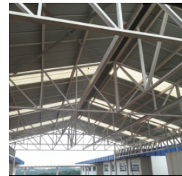
Vista do pátio coberto
