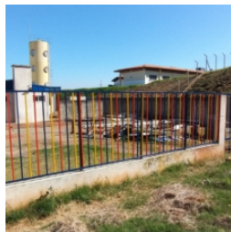
Vista frontal da obra - pintura do gradil sobre o muro
