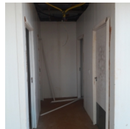
Vista interna do bloco pedagógico
