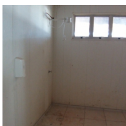
Vista interna do bloco de serviço
