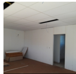
Vista interna do bloco pedagógico
