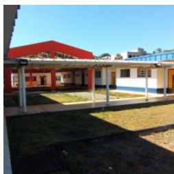
Vista geral da obra
