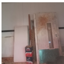
Vista interna do bloco administrativo
