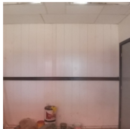
Vista interna do bloco de serviço
