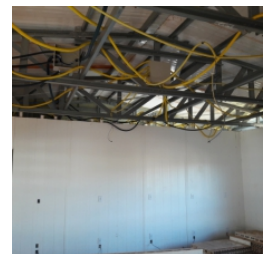
Vista interna do bloco pedagógico
