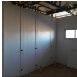
Vista interna do bloco pedagógico
