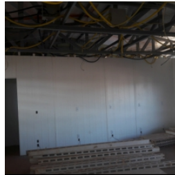
Vista interna do bloco pedagógico
