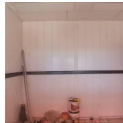
Vista interna do bloco administrativo
