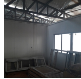
Vista interna do bloco administrativo
