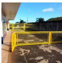
Execução parcial dos gradis no solário do bloco pedagógico lado direito
