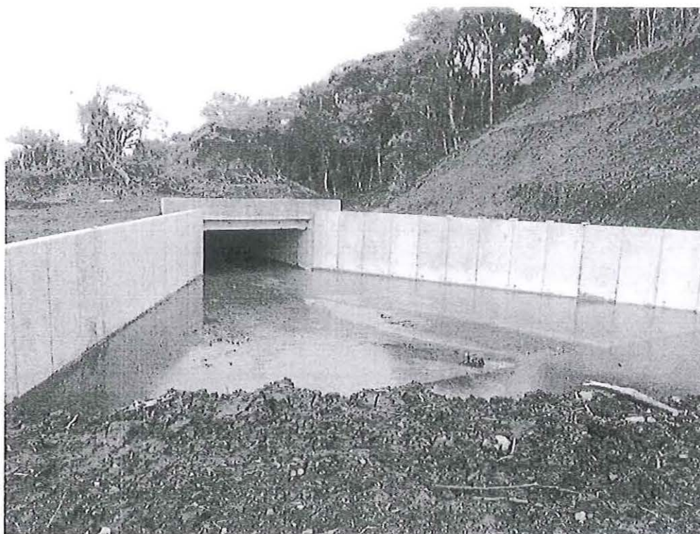
Fotografia 02 – Estrutura dos Vertedouros – Vista 02
