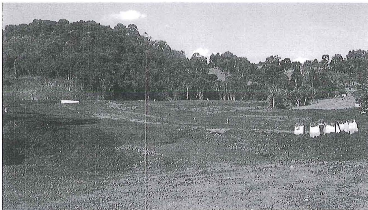
Fotografia 04 – Escavação e Locação Convencional de Obra
