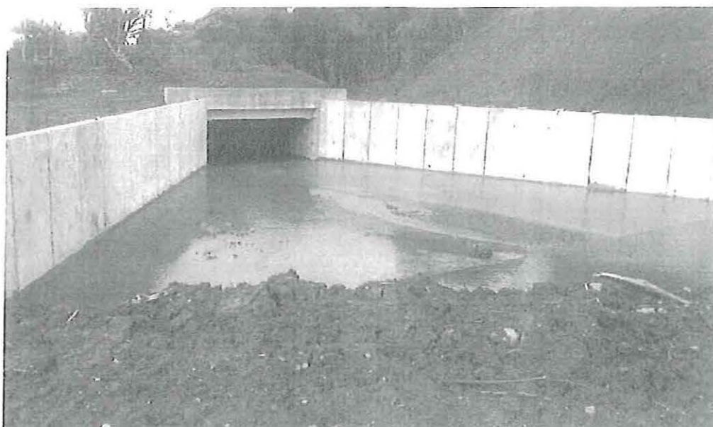
Fotografia 02 – Estrutura dos Vertedouros / Canal de Aproximação – Vista 02
