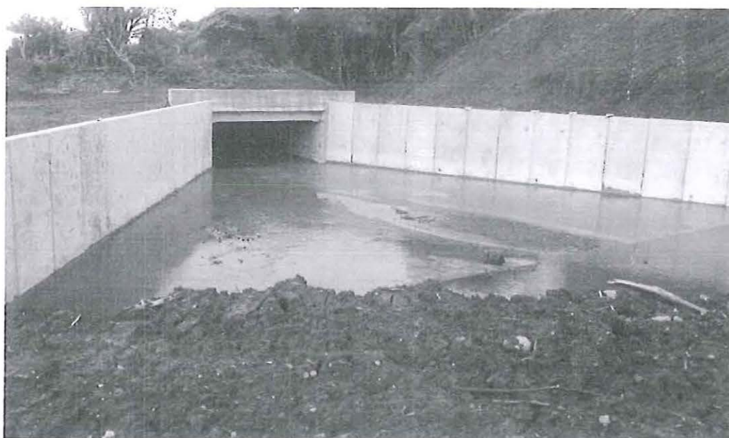
Fotografia 02 – Estrutura dos Vertedouros / Canal de Aproximação – Vista 02
