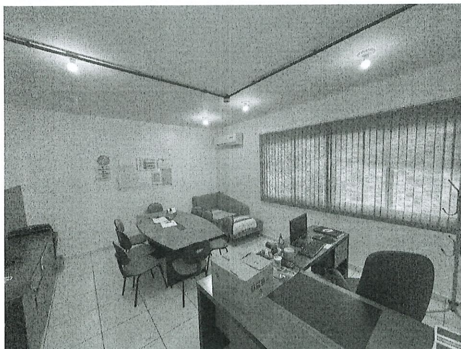
Figura 8 – Elétrica com canaleta exterior. Fonte: Autor
