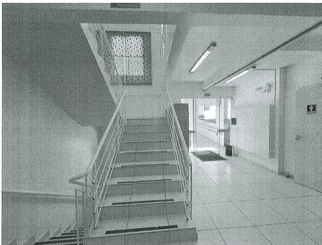
Figura 10 - Hall, piso cerâmico, iluminação de sobrepôr, teto laje sem rebaixo. Fonte: Autor.
