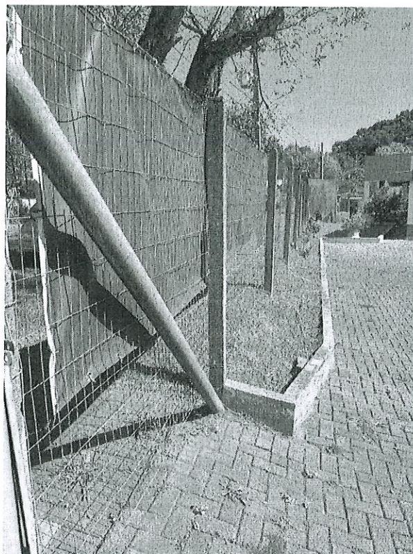
Figura 5 - Pilar de concreto e tela de alambrado no perímetro do imóvel. Fonte: Autor.
