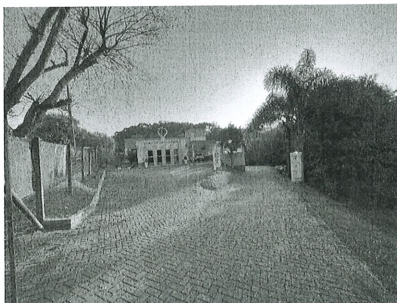
Figura 4 - Acesso em paver e a direita nota-se desnível do terreno. Fonte: Autor.
