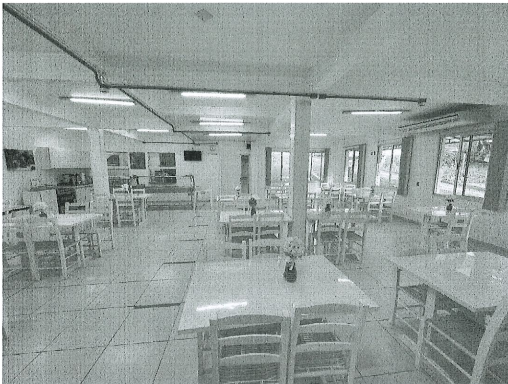
Figura 9 - Refeitório: Piso cerâmico, tubulação elétrica exterior. Fonte: Autor.
