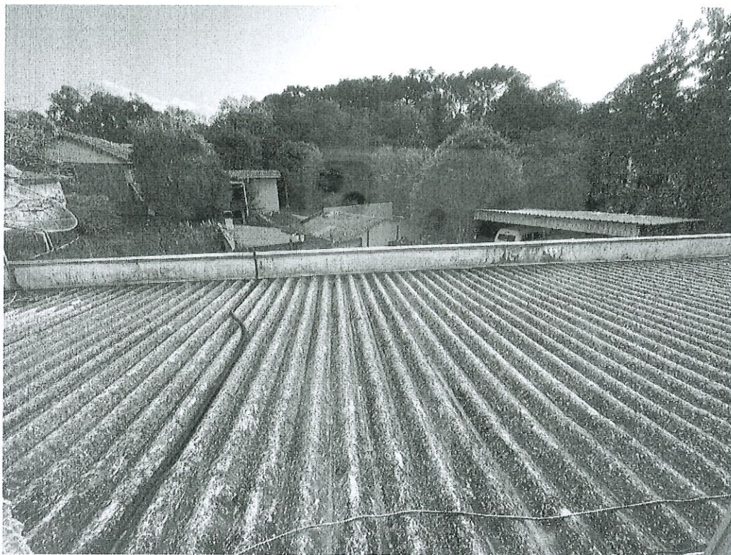
Figura 13 – Cobertura em fibrocimento. Fonte: Autor.
