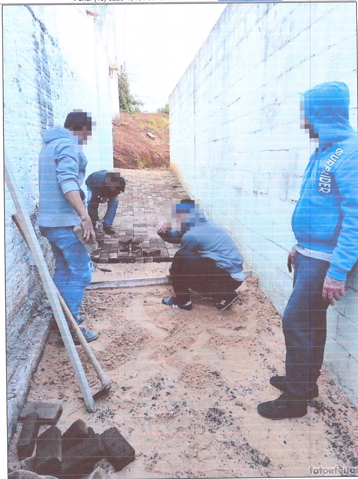
- Foto 45 – Colocação de paiver realizado pelos recuperandos.
