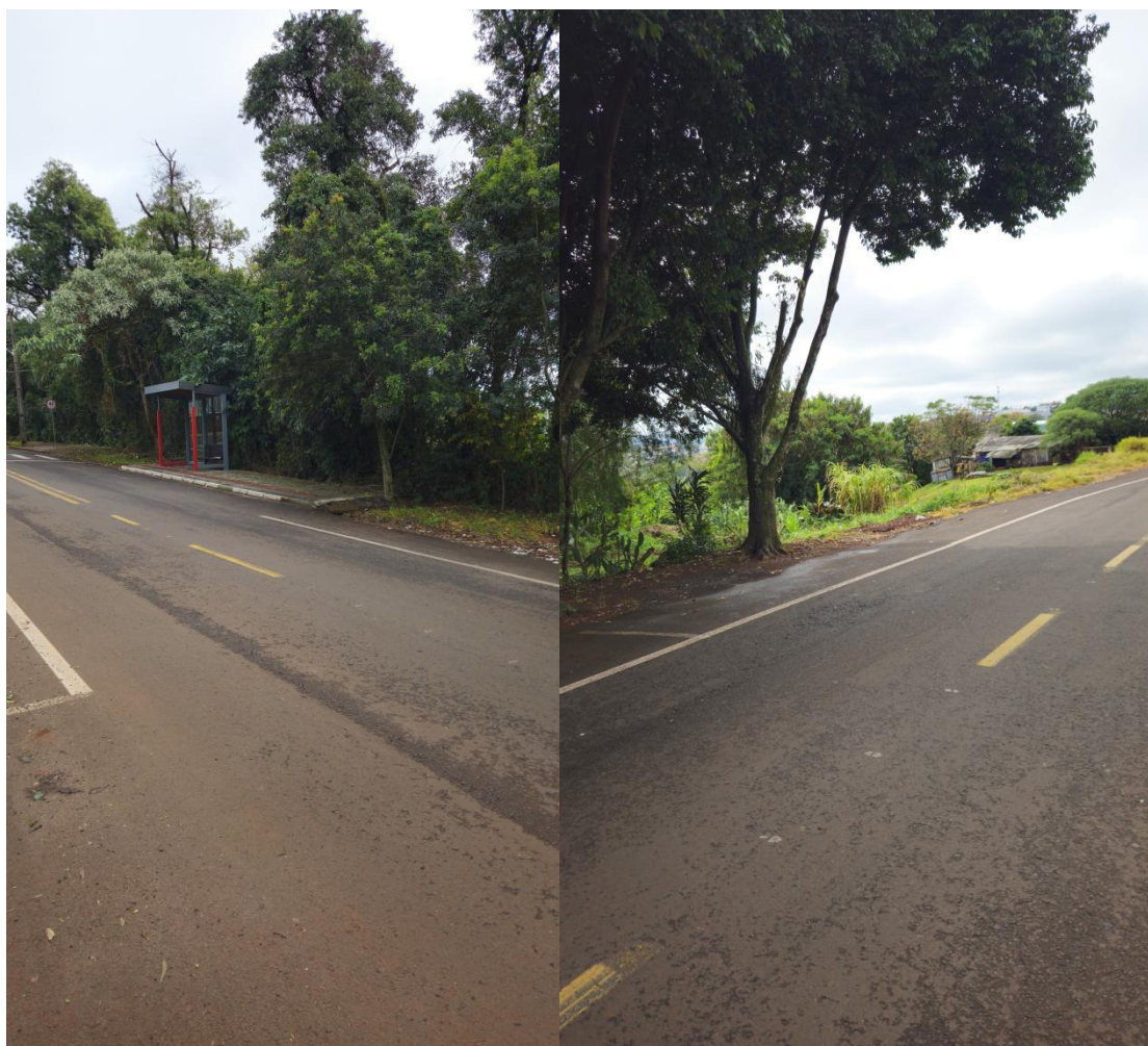
Foto: trecho da rua Marília sem acessibilidade
